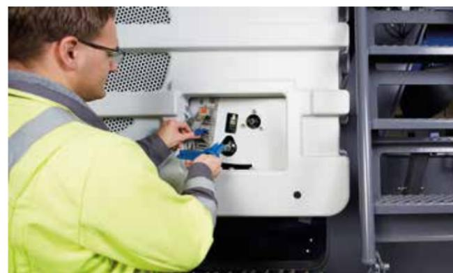
> Insertar el elemento de control en la estación de liberación; el rotor está bloqueado de forma segura y las llaves están liberadas para otros pasos.
