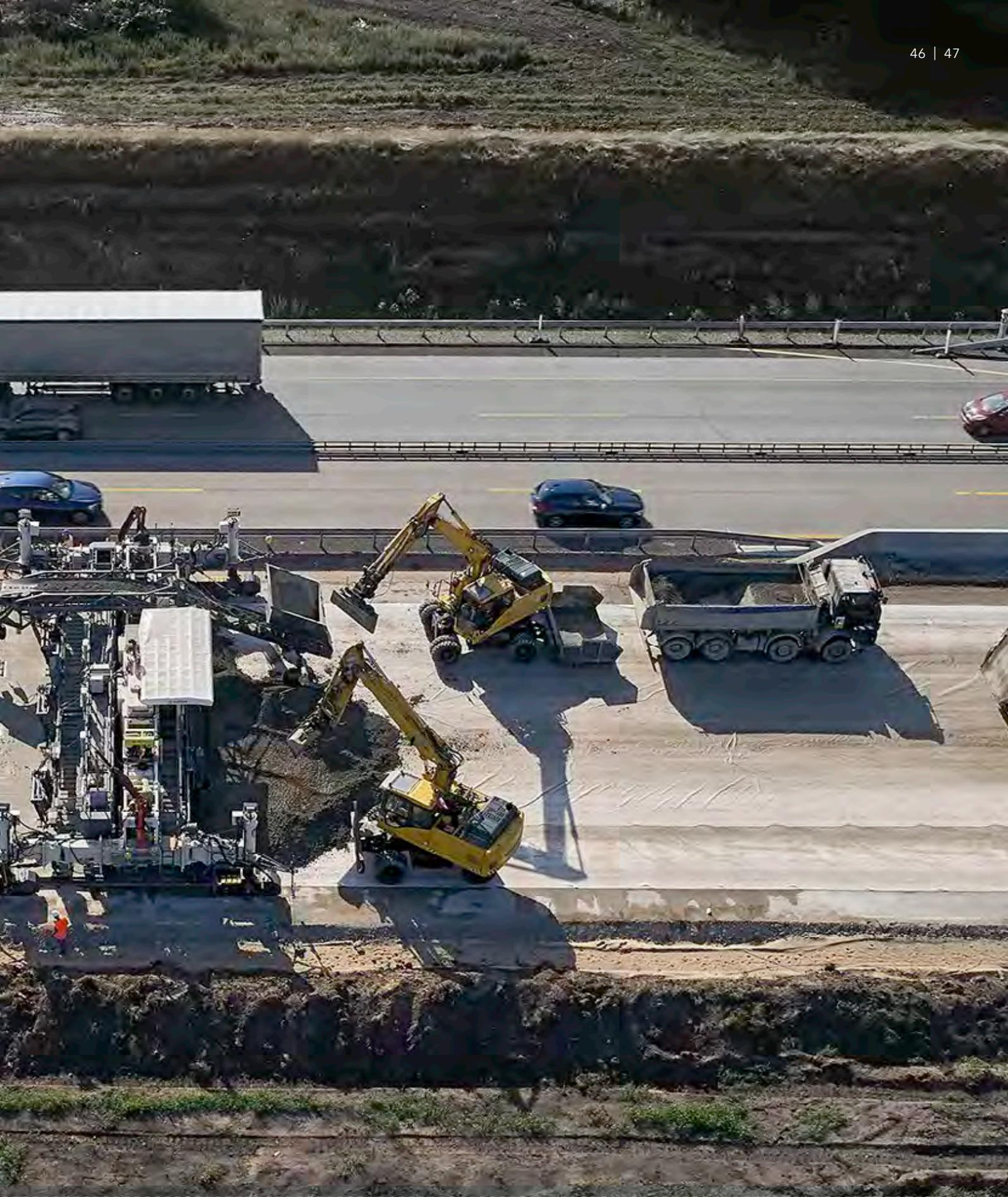
La gamma dei prodotti completa di WIRTGEN per le finitrici a casseforme scorrevoli inset copre tutte le classi di potenza e gli ambiti di applicazione. Le larghezze di stesa standard per le pavimentazioni di calcestruzzo vanno da 1,0 m a 16,0 m con uno spessore di stesa standard di 450 mm.
