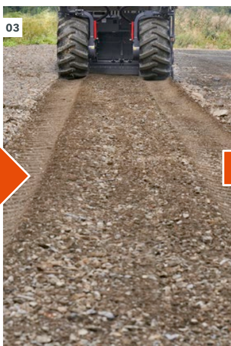
03 Resultado de trituração e mistura: avalie e reajuste os parâmetros, se necessário
