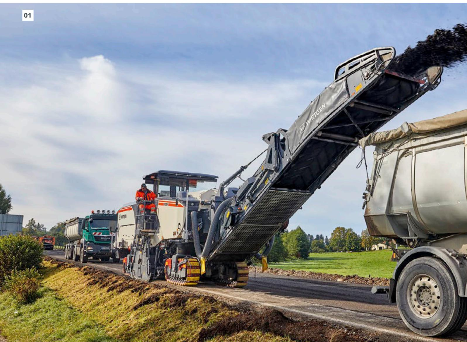
**01** O material de fresa- gem removido é geral- mente reutilizado como um valioso material de constru- ção reciclado.
