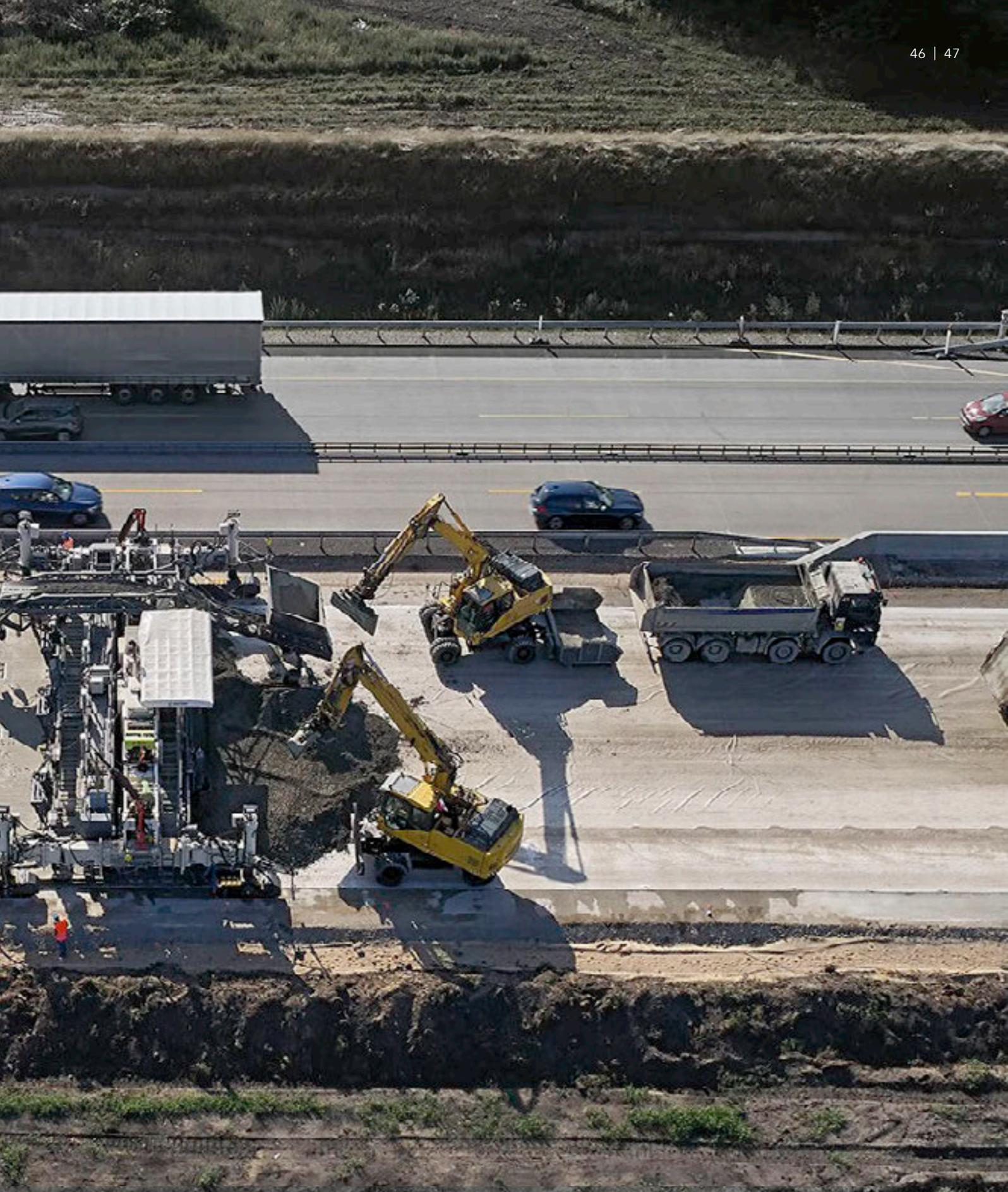
El programa de suministro integral de WIRTGEN de extendedoras de encofrado deslizante entre orugas cubre todas las clases de potencia y campos de aplicación. Las anchuras de extendido estándar de capas de hormigón van desde 1,0 m hasta 16,0 m con un espesor de extendido estándar de hasta 450 mm.cke.
