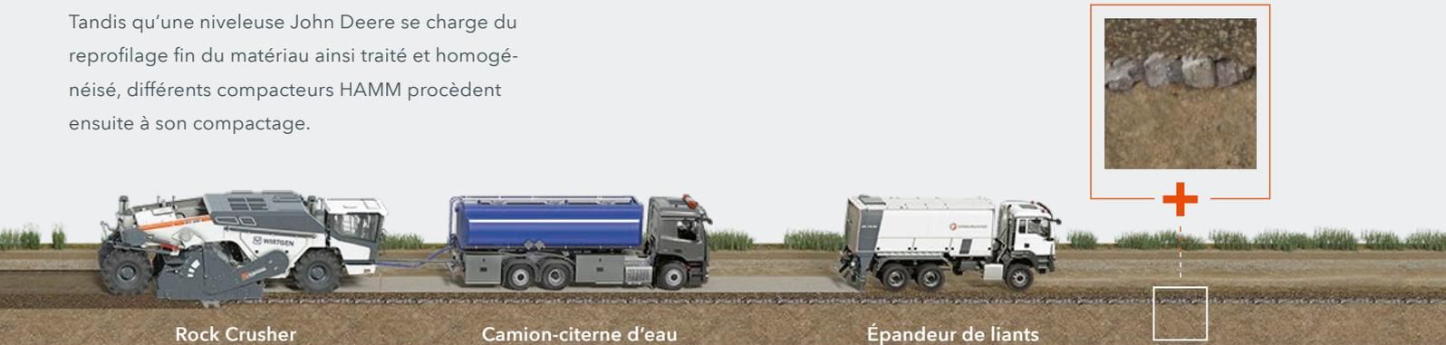
Tandis qu'une niveleuse John Deere se charge du reprofilage fin du matériau ainsi traité et homogénéisé, différents compacteurs HAMM procèdent ensuite à son compactage.
