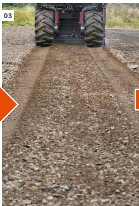
**03** Résultat de concassage et de malaxage : évaluer et éventuellement ajuster les paramètres
