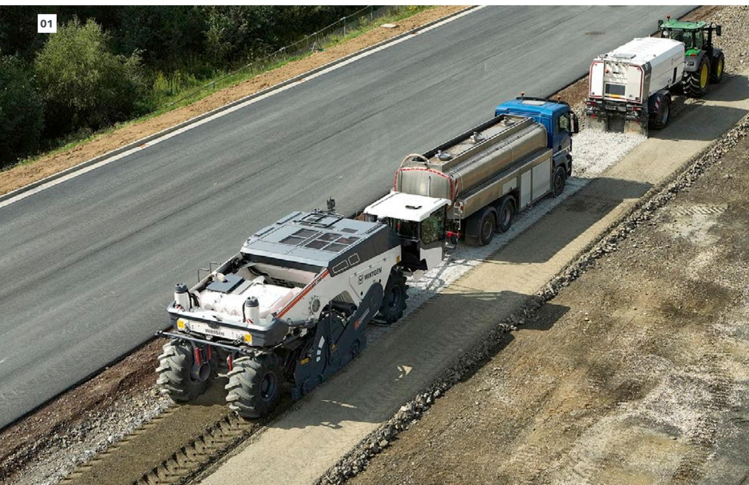
Dans certains cas d'application, il est important de réduire uniquement la teneur en vides et d'améliorer la constance de volume. Il peut être suffisant de concasser le matériau existant et de le mélanger sans ajout de liant. Le concassage ou l'homogénéisation permet de produire le calibre requis avec une distribution homogène et constante et ainsi d'atteindre la capacité portante souhaitée.
