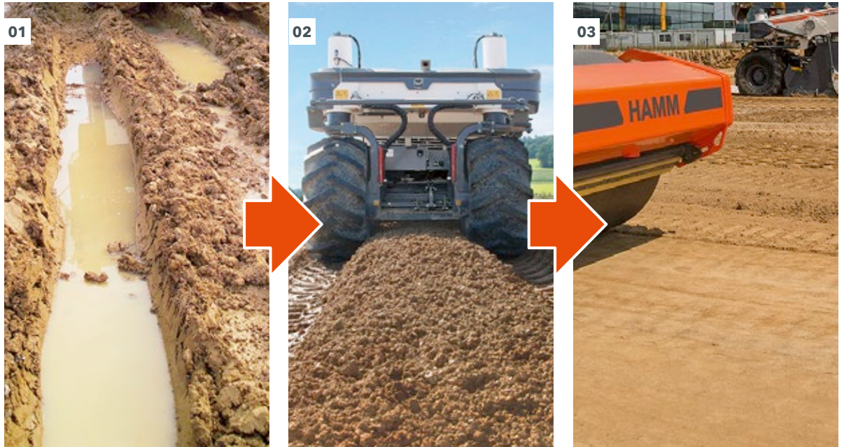
01 - 04 Durante la estabilización se transforma el subsuelo que presenta una capacidad de carga insuficiente en un suelo apto para el extendido y la compactación.
