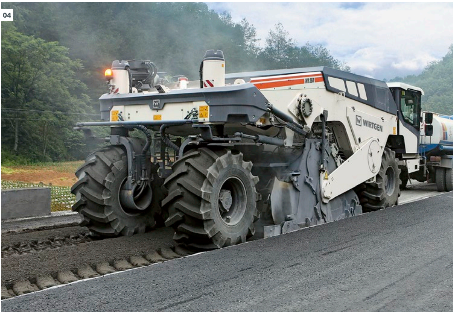
01 - 04 Durante el reciclaje en frío se granulan capas de asfalto dañadas, se mezclan con ligante, se tratan, se compactan y se vuelven a extender.
