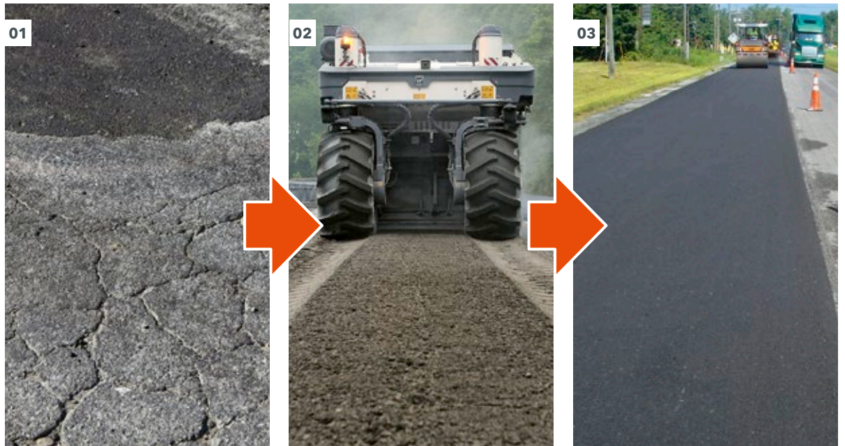
01 - 04 Durante el reciclaje en frío se granulan capas de asfalto dañadas, se mezclan con ligante, se tratan, se compactan y se vuelven a extender.
