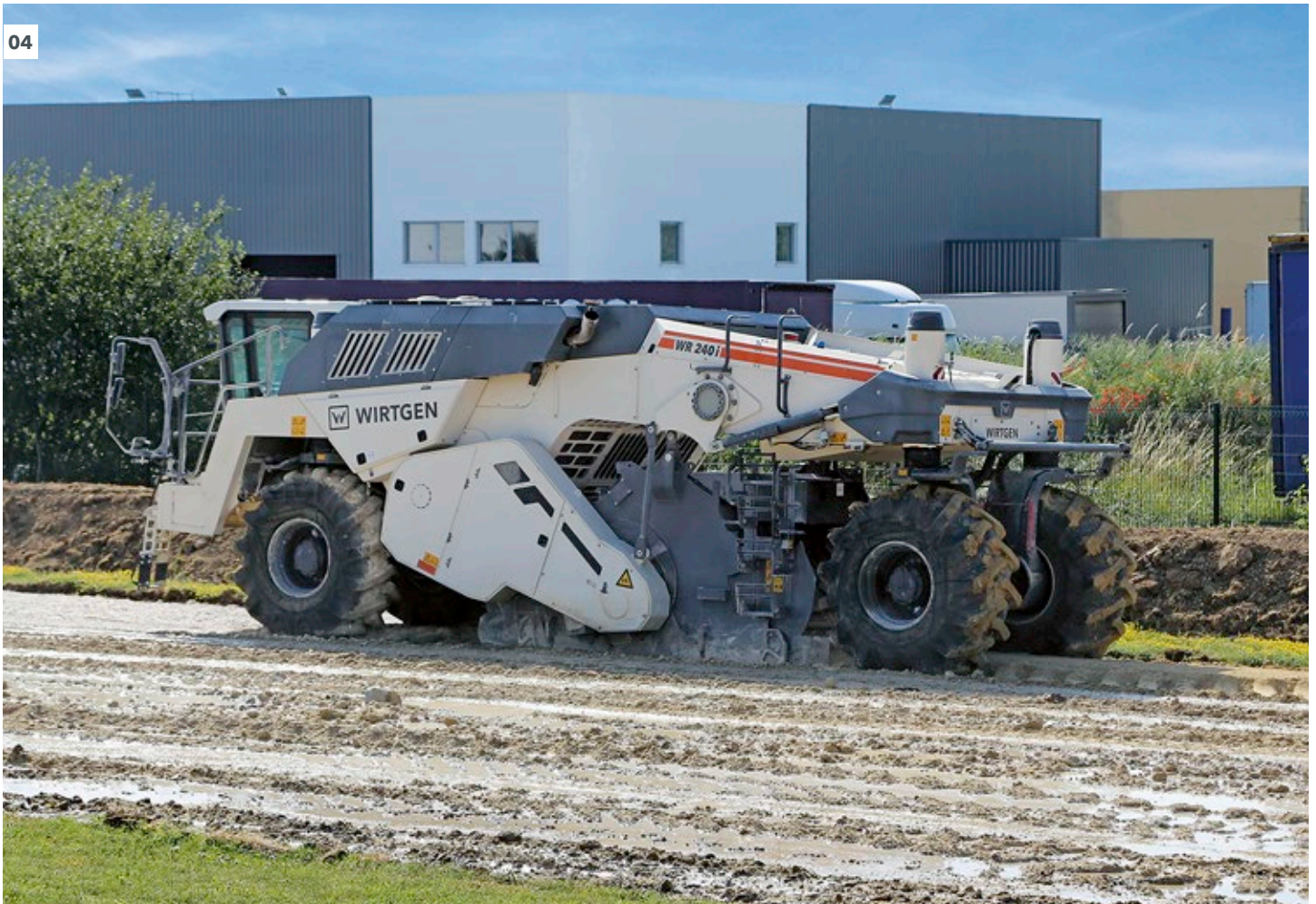
01 - 04 Durante la estabilización se transforma el subsuelo que presenta una capacidad de carga insuficiente en un suelo apto para el extendido y la compactación.
