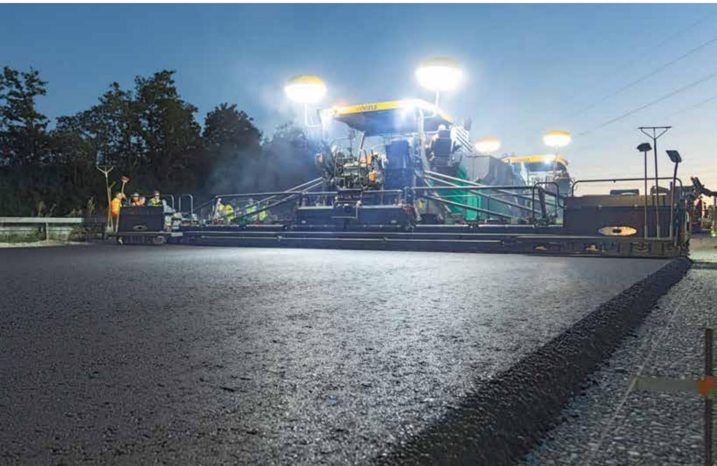
> Innovador concepto de transferencia de material y el enorme túnel de material (162 x 50 cm) posibilitan una capacidad de transporte de hasta 1800 t/h.
