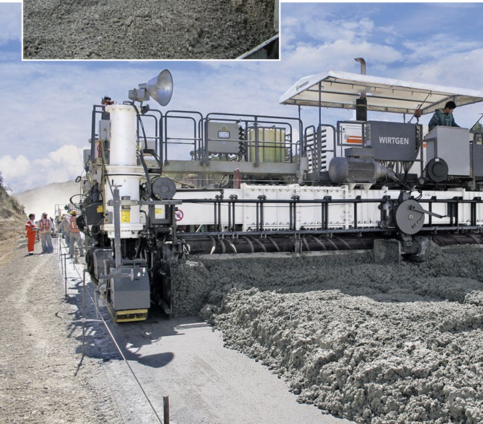
01 - 02 正铺施工:使用布料搅龙或布料犁均匀分布混凝土。
