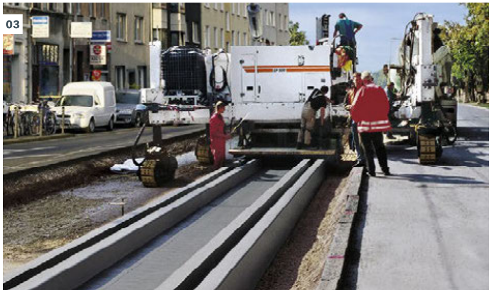
03 高精度摊铺城际铁路或高速铁路道床。
