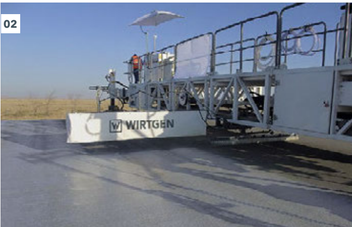
01 拖动麻布进行拉毛处理，使混凝土路面形成细密的纹理。 02 - 03 拉毛养生机使路面形成规定的纹理，例如，拖动拉毛刷子，同时喷洒养护剂。
