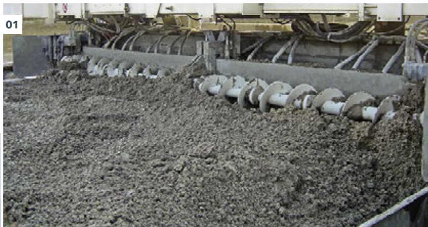
01 - 02 正铺施工:使用布料搅龙或布料犁均匀分布混凝土。
