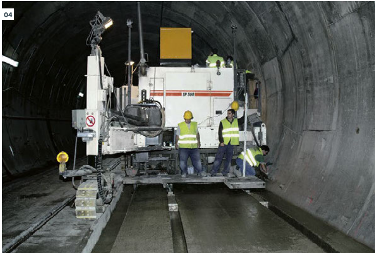
04 使用无线控制技术, 可以实现有限空间的零距离摊铺。
