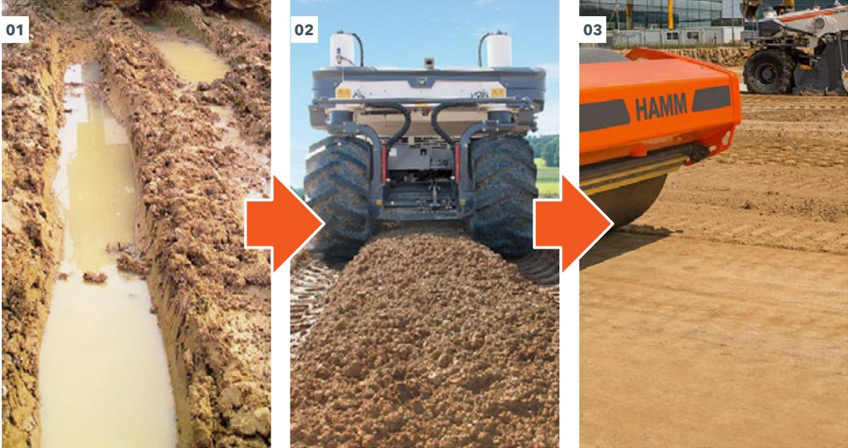
01 - 04 La stabilisation de sols consiste à transformer un sol peu portant en un sol adapté à la pose et au compactage.
