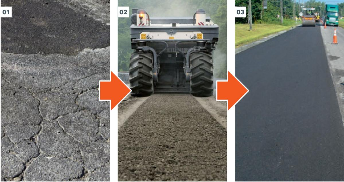
01 - 04 Le recyclage à froid consiste à concasser des couches d'asphalte endommagées, à les mélanger à des liants, les traiter, les compacter puis à les poser à nouveau.
