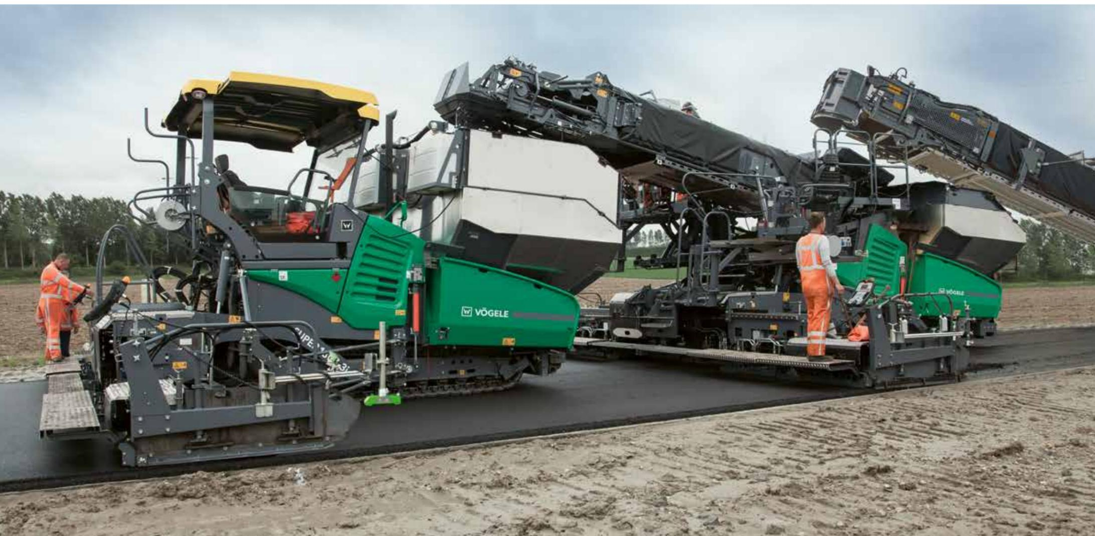
Das Förderband ist beheizt, um ein Festkleben von Material zu verhindern. Zwischen Binderschichtfertiger und Deckenfertiger sorgen eine weitere elektronische Abstandsregelung und ein Auffahrschutz für die nötige Sicherheit.
